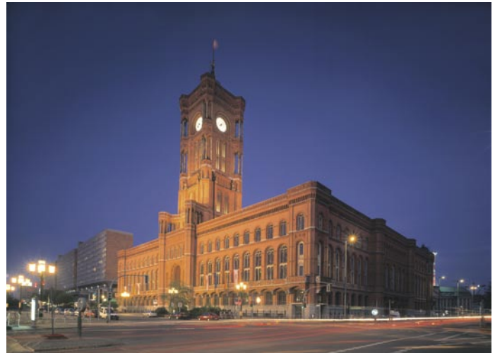
Klimaschutz und Kostensenkung mit der Energiesparpartnerschaft Berlin – auch im Roten Rathaus erfolgreich
