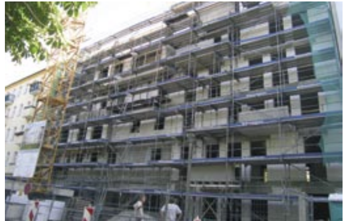
... Straßensicht der Baustelle im August 2008 (Foto: F. Herzog)
