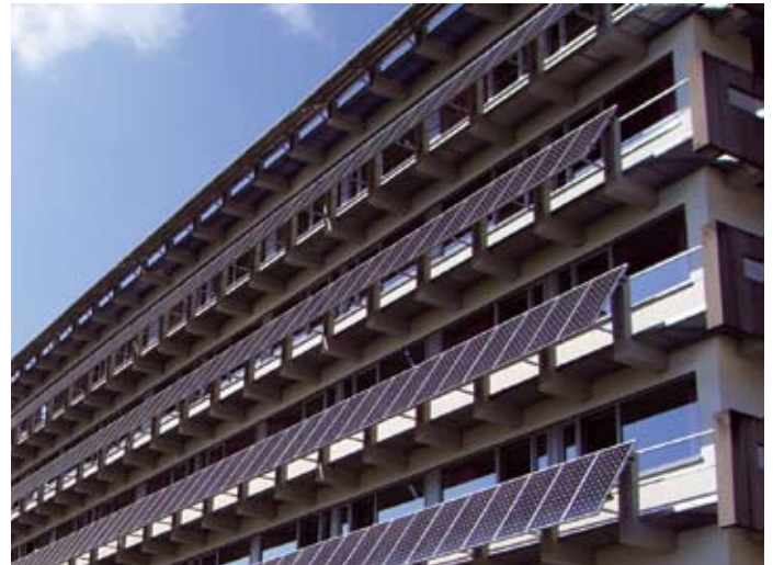
Photovoltaik-Anlage am Krankenhaus Mühlacker
