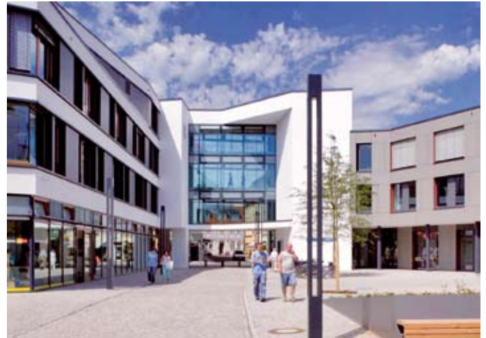
Das Paul-Wunderlich-Haus in Eberswalde von den Berliner Architekten GAP zeigt, wie nachhaltigkeitsorientierte Ziele bei einem öffentlichen Bauvorhaben umgesetzt werden können. Wegen seiner Vorbildlichkeit und Ganzheitlichkeit in Bezug auf nachhaltiges Bauen wurde dieses Projekt auch für die Pilotzertifizierung nach dem derzeit in Entwicklung befindlichen Zertifizierungssystem „Deutsches Gütesiegel Nachhaltiges Bauen“ ausgewählt. Darüber hinaus stellt das Projekt einen Teil der Präsentation dar, für die das Deutsche Team bei der World Sustainable Building Conference SBO8 in Melbourne im September als „Overall winner“ für die beste Präsentation ausgezeichnet wurde.
