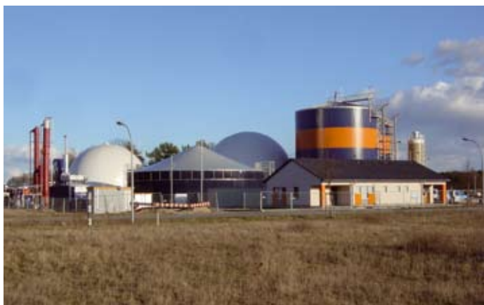
Die Biogasanlage Rathenow im Versorgungsgebiet der EMB Erdgas Mark Brandenburg GmbH hat Gestalt angenommen – Ansicht Nord. Quelle: ALENSYS Engineering GmbH
